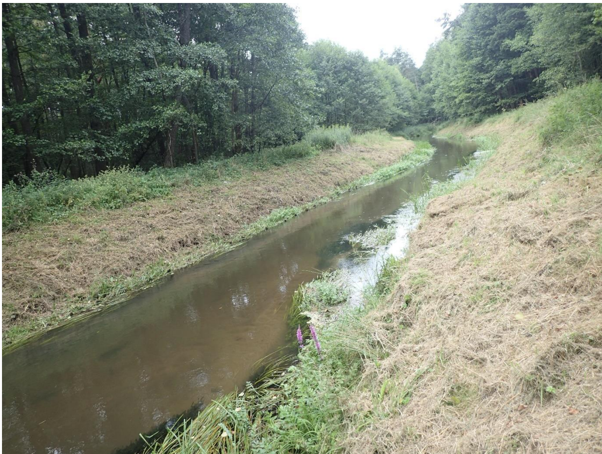
Fot. 18. Uregulowany i utrzymywany w sposób inwazyjny dla siedliska odcinek Bytowej. Fot. Andrzej Jermaczek
