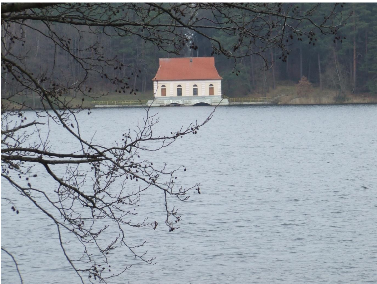
Fot. 14. Wodny „zamek” na jez. Głębokim, w miejscu poboru wody na potrzeby elektrowni w Gałąźni. Fot. Andrzej Jermaczek
