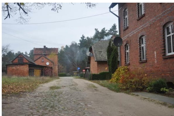
Fot. 70 Droga brukowa w m. Soszyca. (Fot. Kasprzak A., 2020)
