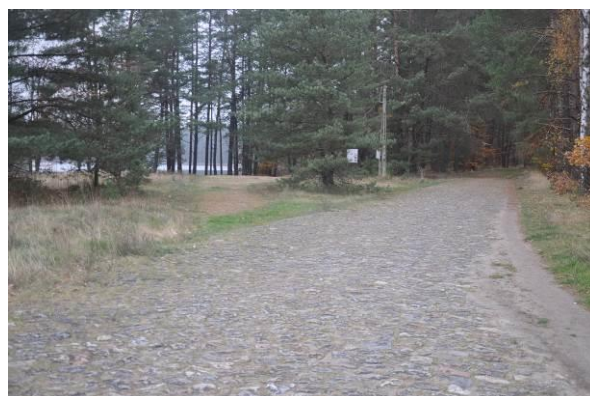
Fot. 71 Droga brukowa w m. Soszyca. (Fot. Kasprzak A., 2020)
