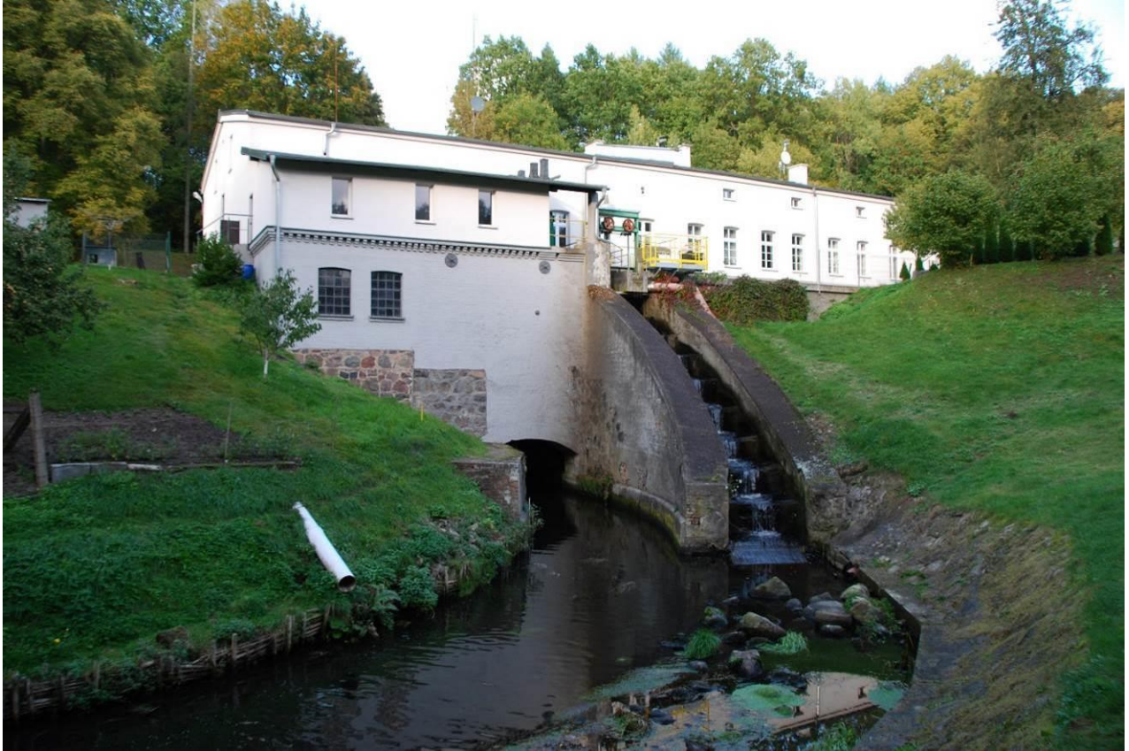
Fot. 101 Elektrownia wodna Skarszów Dolny. (Fot. Wasilewski M., 2020)
