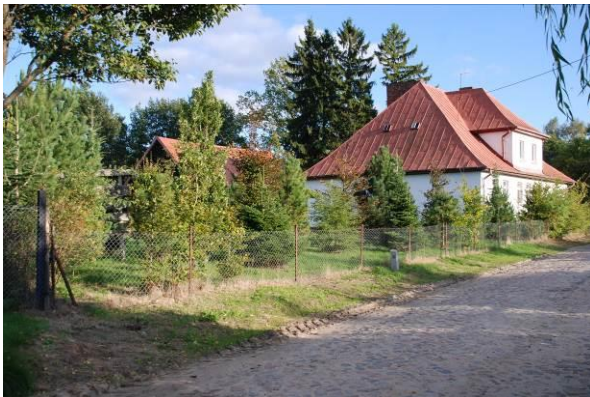
Fot. 58 Droga brukowa w m. Żelki. (Fot. Kasprzak A., 2020)
