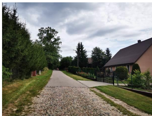
Fot. 87 Droga brukowa w m. Wierszyno. Fragment bruku został przykryty asfaltem. (Fot. Wasilewski M., 2021)
