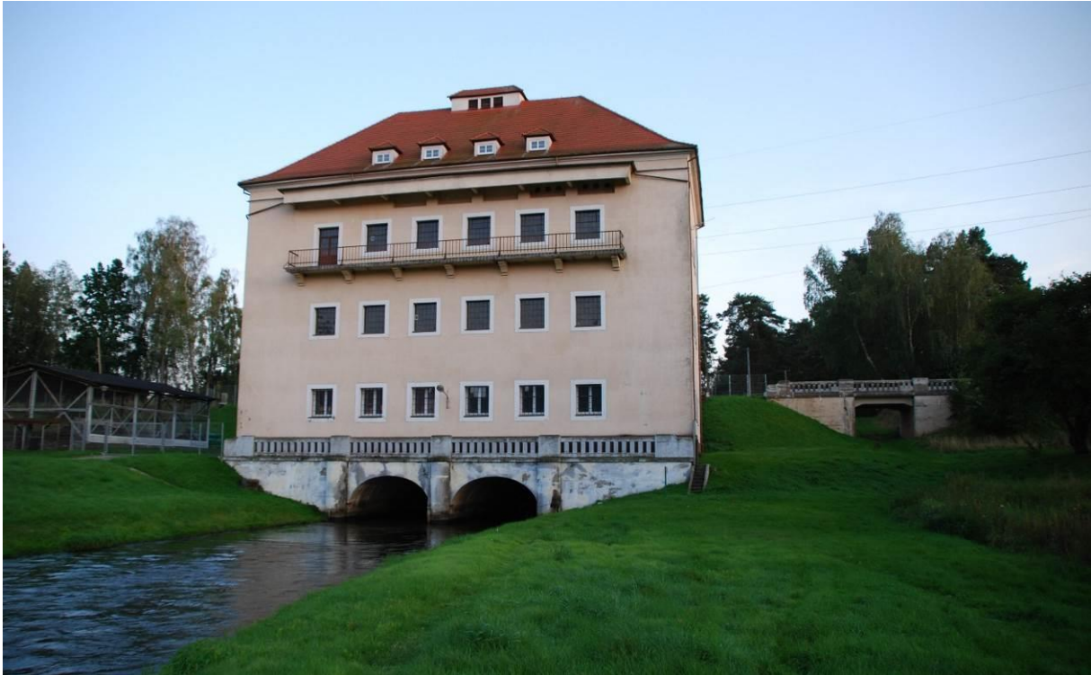
Fot. 100 Elektrownia wodna w Krzyni. (Fot. Wasilewski M., 2020)
