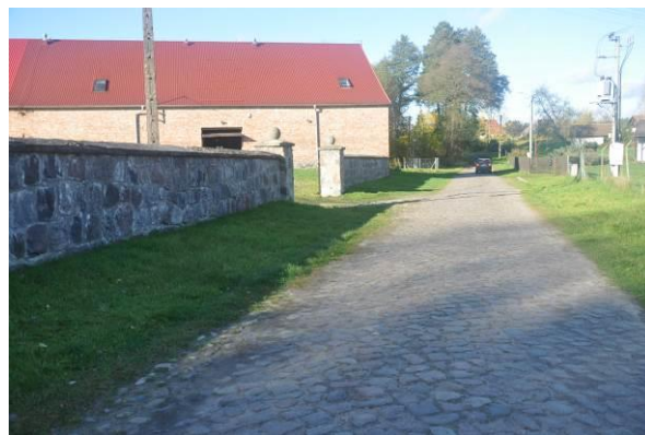
Fot. 61 Droga brukowa w m. Żelkówko. (Fot. Kasprzak A., 2020)
