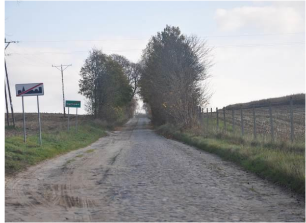
Fot. 55 Droga brukowa Kwakowo-Komiłowo. (Fot. Kasprzak A., 2020)
