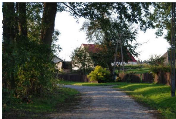
Fot. 62 Droga brukowa w m. Żelkówko. (Fot. Kasprzak A., 2020)
