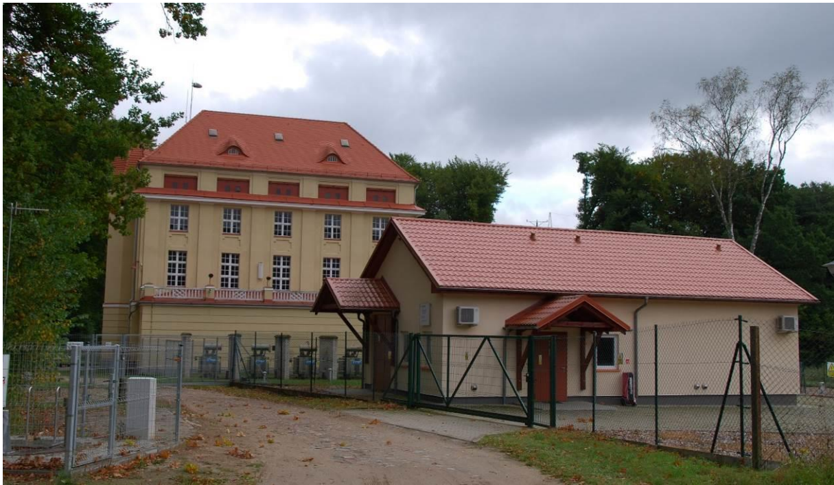
Fot. 96 Elektrownia wodna w Gałąźni Małej. (Fot. Kubiec K., 2020)
