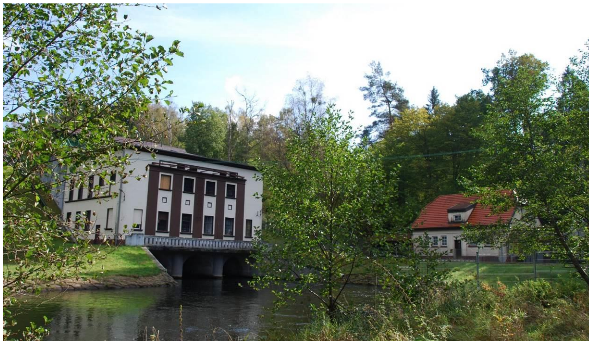
Fot. 98 Elektrownia wodna Strzegomino. (Fot. Kubiec K., 2020)
