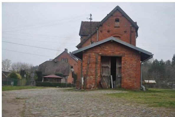
Fot. 72 Droga brukowa w m. Soszyca. (Fot. Kasprzak A., 2020)
