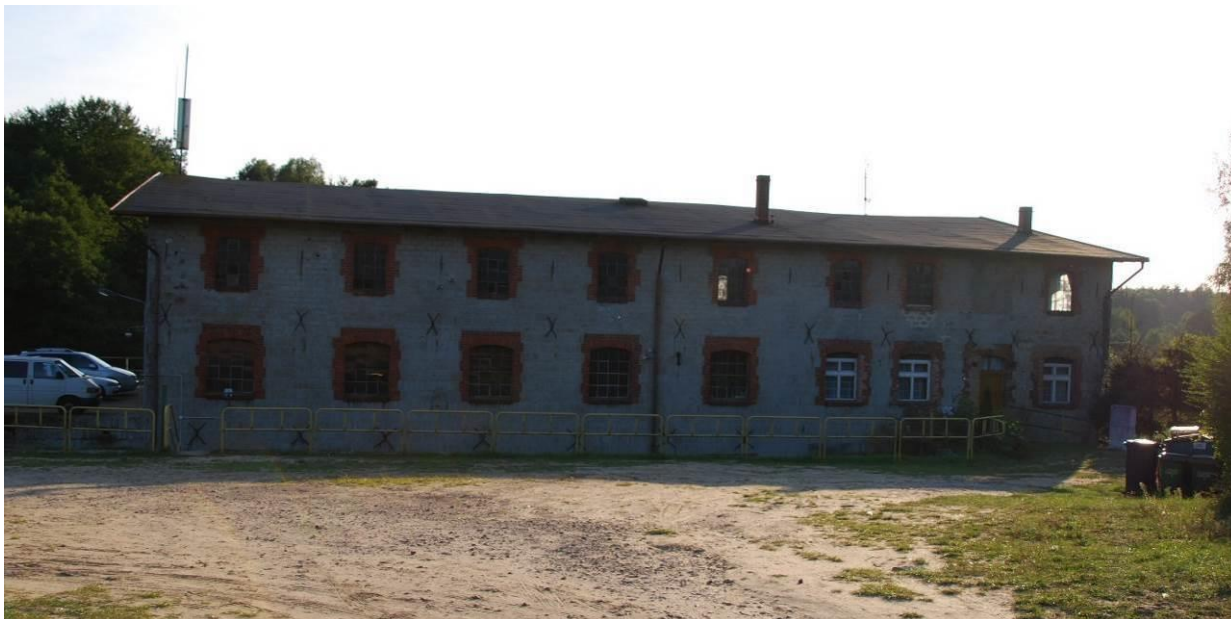
Fot. 95 Elektrownia Struga. (Fot. Kubiec K., 2020)
