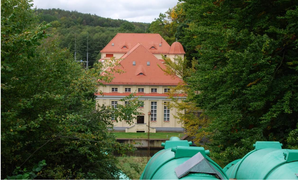
Fot. 97 Elektrownia wodna w Gałężni Małej. (Fot. Kubiec K., 2020)
