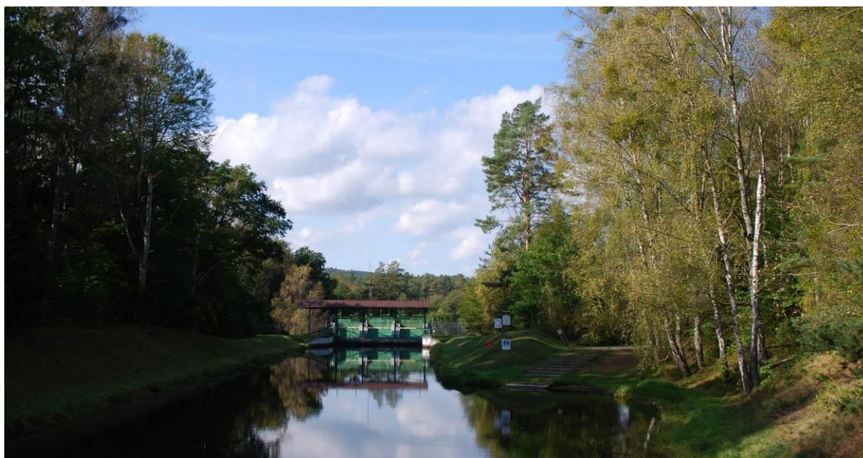
Fot. 99 Elektrownia wodna Strzegomino. (Fot. Kubiec K., 2020)
