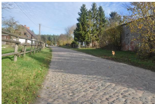
Fot. 60 Droga brukowa w m. Żelkówko. (Fot. Kasprzak A., 2020)
