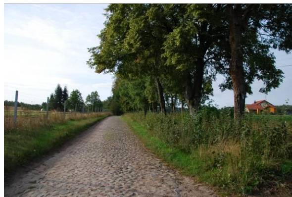
Fot. 85 Droga brukowa w m. Wierszyno. (Fot. Wasilewski M., 2020)
