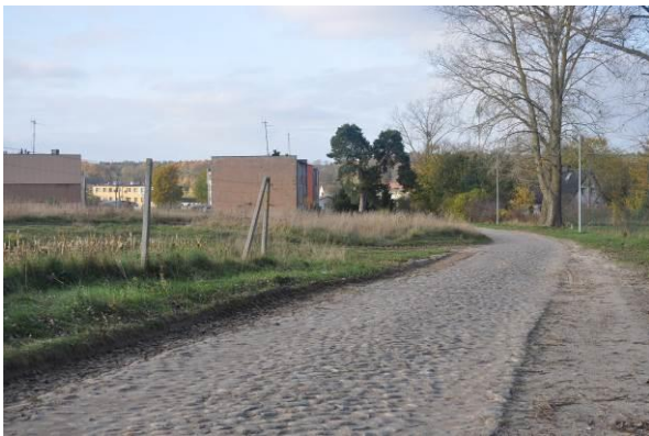
Fot. 56 Droga brukowa Kwakowo-Komiłowo. (Fot. Kasprzak A., 2020)
