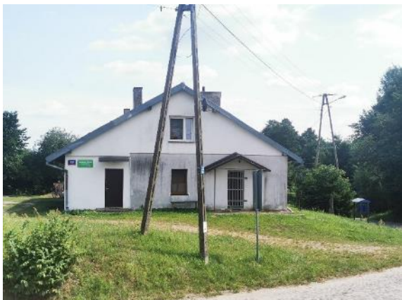
Ryc. 200 Świetlica Wiejska w ŻelkóWKu (Fot. MW, 2021)
