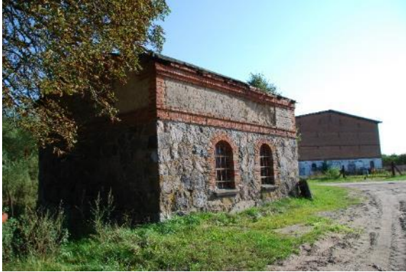
Ryc. 149 Jerzkowice – zabytkowa zabudowa (Fot. MW, 2020)
