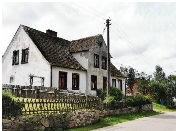
Ryc. 117 Podwilczyn – „remonty” zabudowy zabytkowej (Fot. MW, 2020)
