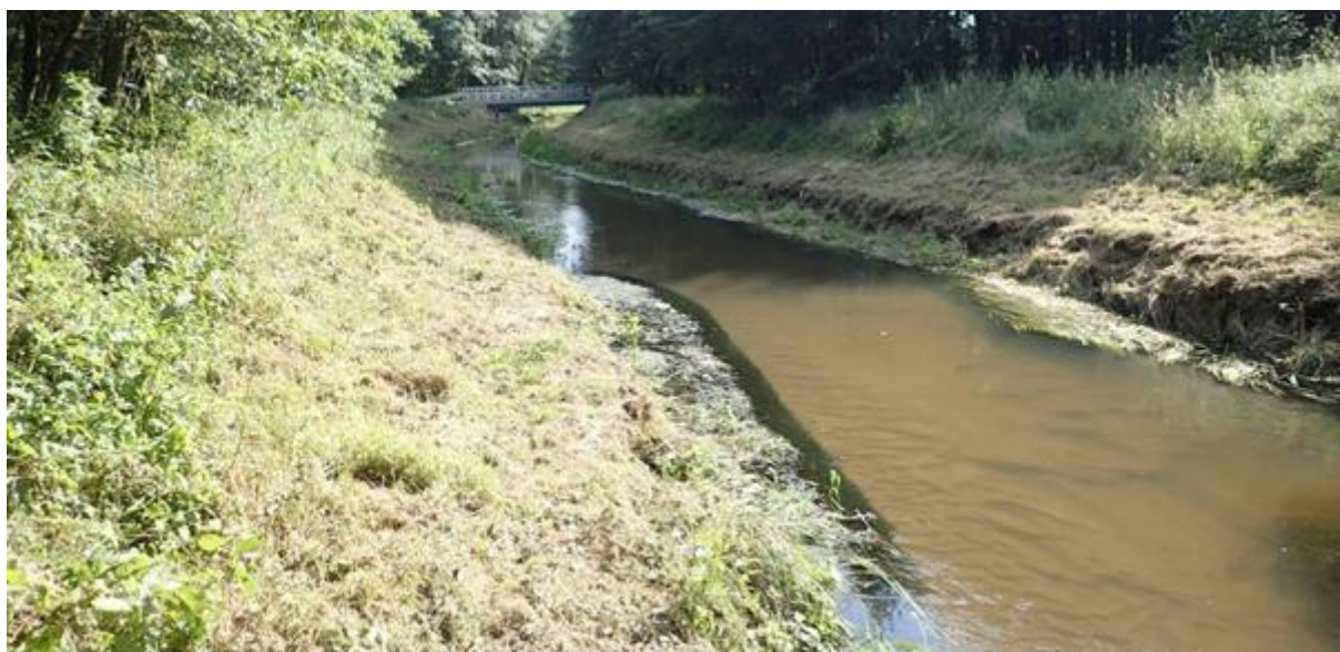
Fot. 17. Fragment koryta Bytowej po pracach utrzymaniowych. Fot. Andrzej Jermaczek
