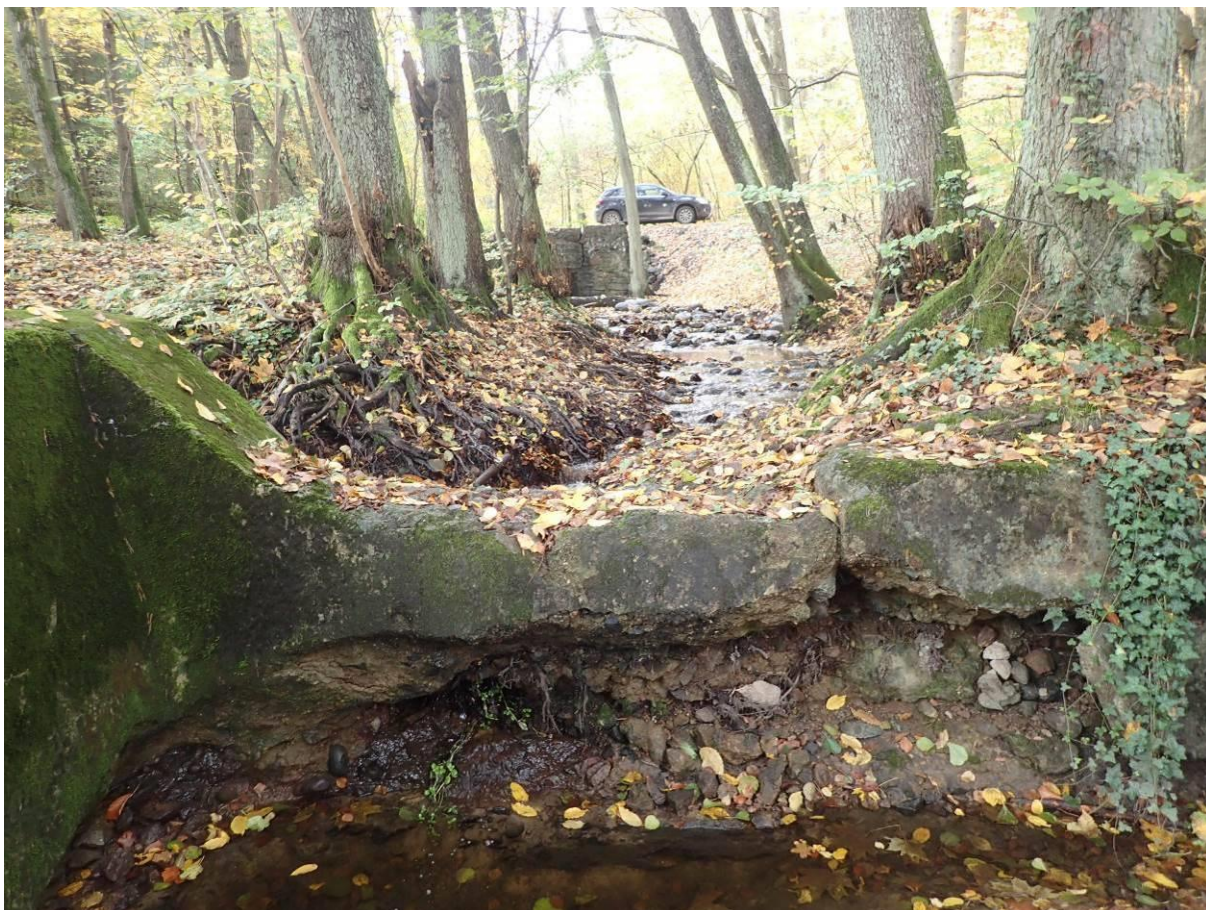
Fot. 52. Pozostałość betonowego progu na rzece Kacza. Fot. Andrzej Jermaczek
