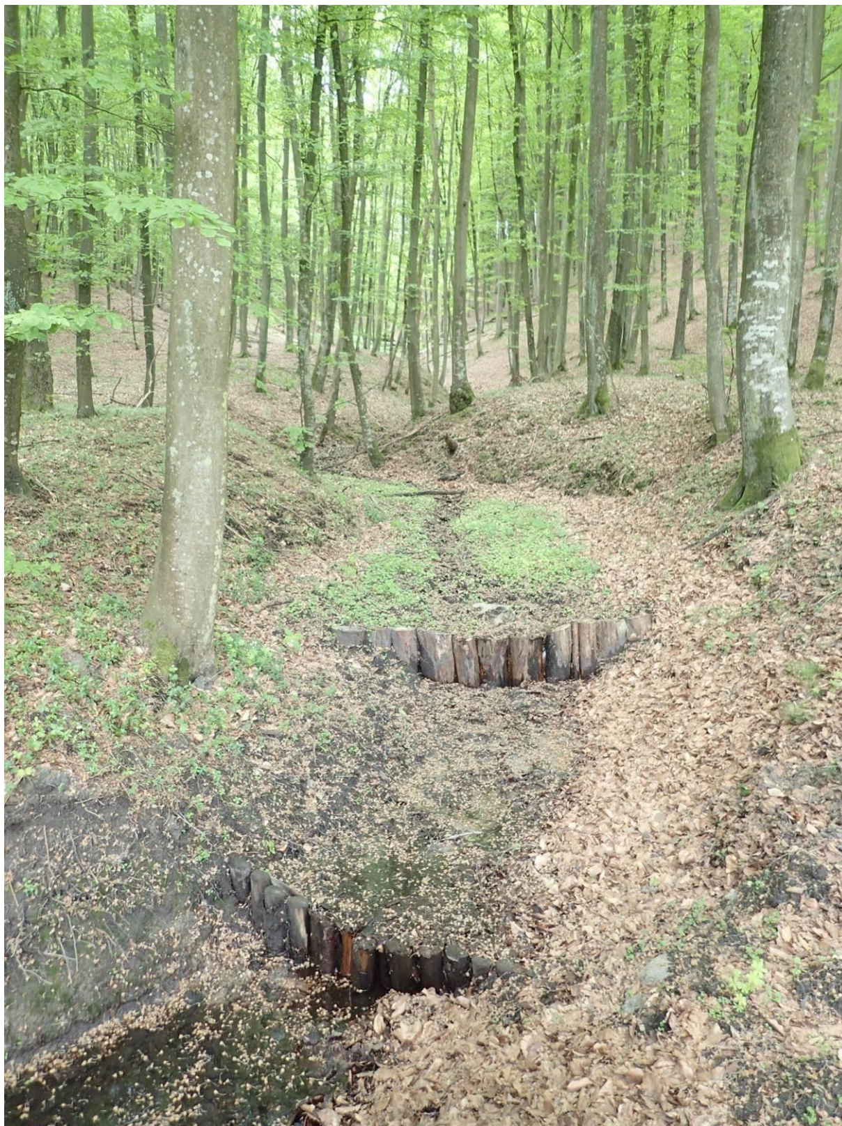
Fot. 17. Zabudowa rynien erozyjnych na gruntach Nadleśnictwa Gdańsk. Fot. Andrzej Jermaczek
