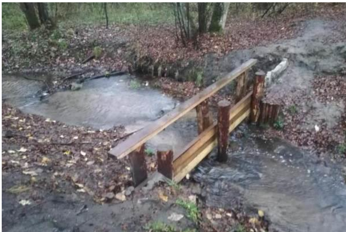
Fot. 19. Urządzenie dolnoprzepustowe, drewniane, podpiętrzające ciek – dopuszczalne w przedstawionej skali do stosowania na obszarze TPK i otuliny. Fot. Michał Przybylski
