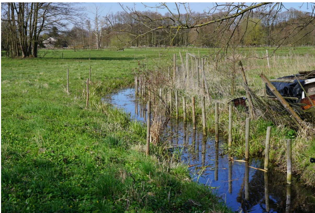
Fot. 13 Rów odwadniający w miejscowości Przebrno (fot. J. Suchożebrski, maj 2021)
