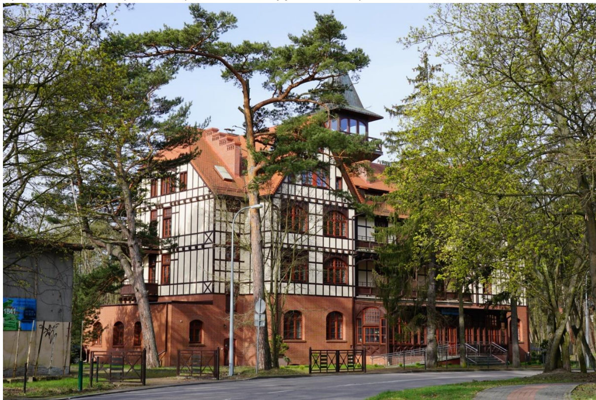
Fot. 3 Zabudowa hotelowa w Krynicy Morskiej (fot. J. Suchożebrski, maj 2021)
