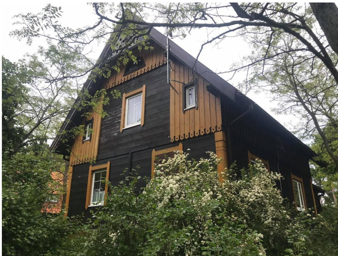
Il. 170: Krynica Morska, ul. Teleexpressu 5;
