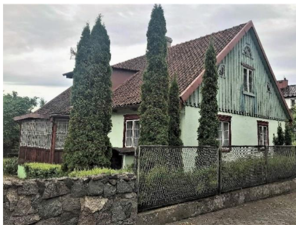
Il. 37: Budynek mieszkalny przy ul. Gdańskiej 30 w Krynicy Morskiej.
