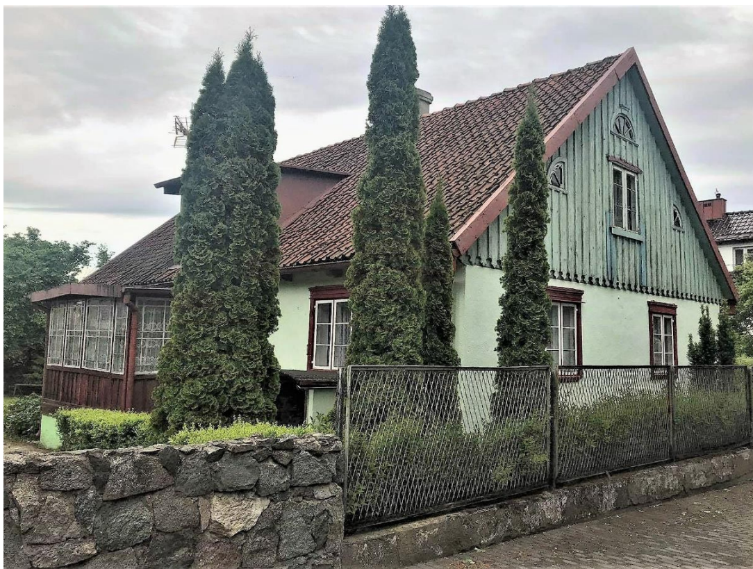
Il. 169: C. Budynek mieszkalny, Krynica Morska, ul. Gdańska 30;
