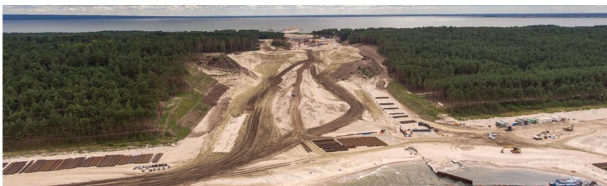
Il. 114: Przekop Mierzei Wiślanej, listopad 2020 r., źródło: https://www.wnp.pl/budownictwo/ .
