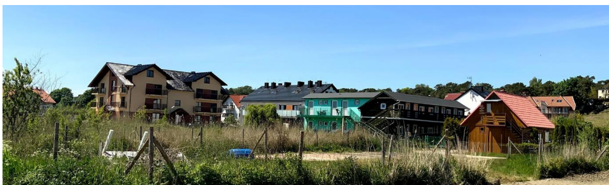
Il. 117: Chaotyczna zabudowa w obrębie historycznych polderów w obrębie Krynicy Morskiej.
