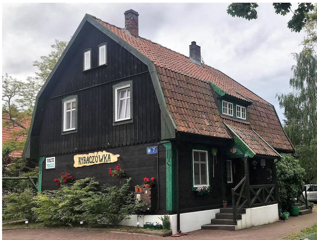
Il. 171: Krynica Morska, ul. Teleexpressu 7.
