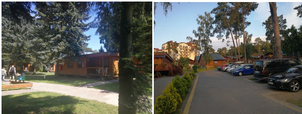
Fot. 19 Zespoły domków jako część ośrodków wypoczynkowych w Skowronkach i Krynicy Morskiej
