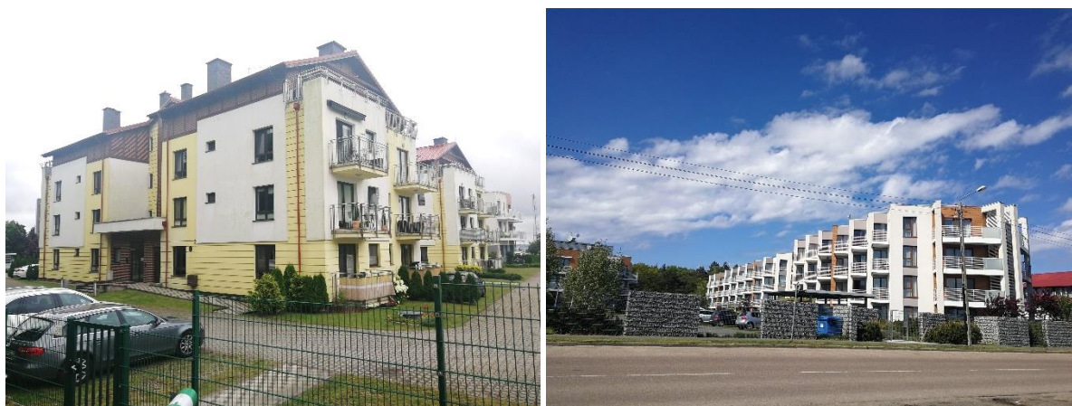
Fot. 12 Apartamenty w Kątach Rybackich (przy ul. Piaskowej, przy ul. Rybackiej)
