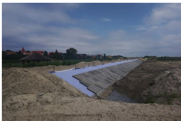
Fot. 40 Budowa wału przeciwpowodziowego koło Krynicy Morskiej (BJS 07.2020)
