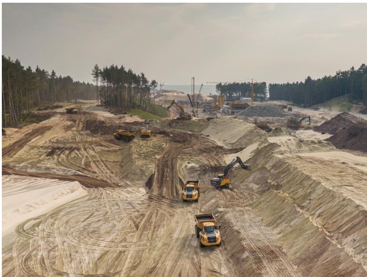
Fot. 51 Centralna część terenu budowy kanału, w głębi Zalew Wiślany – 2020 r. (źródło: https://przekopmierzei.pl )
