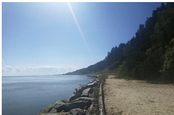
Fot. 39 Narzut kamienny wzdłuż brzegu Zalewu Wiślanego na SW od osady Piaski (BJS 05.2020).
