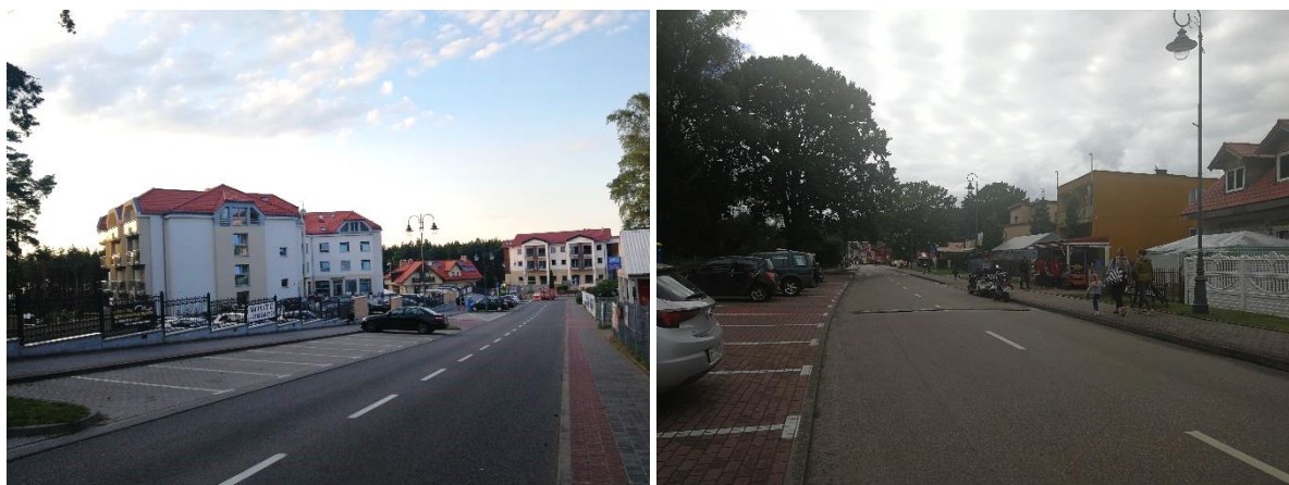
Fot. 36 Ul. Korczaka w Krynicy Morskiej (BJS 07.2020) i ul. Słoneczna w Piaskach (Nowej Karczmie) (BJS 07.2020)
