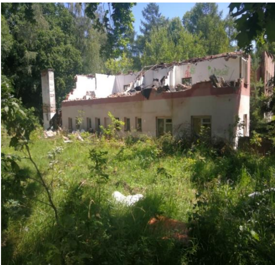
Fot. 45 Odpady budowlane w Przebrnie (BJS 2020) (BJS 07.2020)
