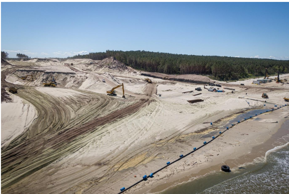
Fot. 53 Teren budowy kanału w strefie brzegowej Zatoki Gdańskiej – 2020 r. (źródło: https://inzynieria.com/fotografie ).
